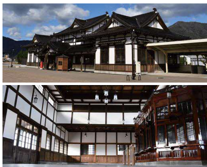
工事が完了した旧大社駅 令和8(2026)年
